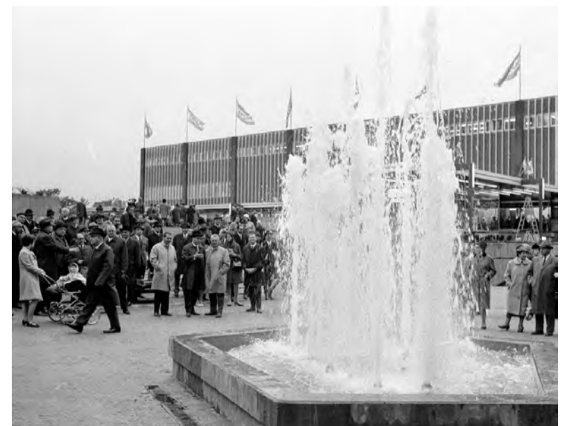
Bereits einen Tag vor der offiziellen Eröffnung am 19. Oktober 1967 strömen die Massen auf den Schillerplatz und zum Brunnen an der Turmstraße.
