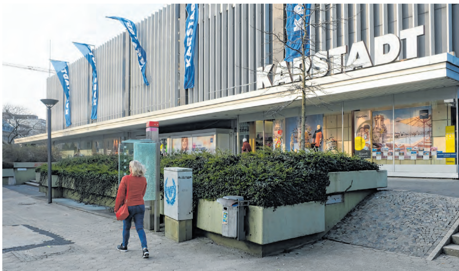
Das Karstadt-Parkhaus gilt als wichtiger Frequenzbringer für die Iserlohner Innenstadt. Auch die Vinckestraße (Bild) soll im Rahmen des Schillerplatz-Projektes grundlegend umgestaltet werden. Die Höhenunterschiede sind unglücklich.
